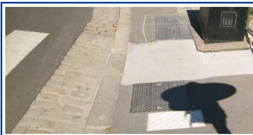
Bande podotactile blanche interrompue suite à des travaux
