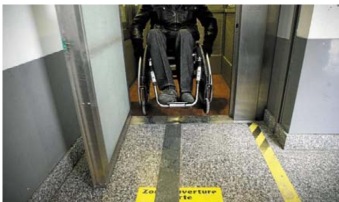
Pour les associations, l'ascenseur de la Poste Lafayette n'est pas fiable.
